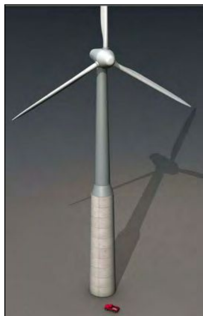
Figura 7: Prototipo de torre híbrida estudiado por BergerABAM (BergerABAM, 2011)
