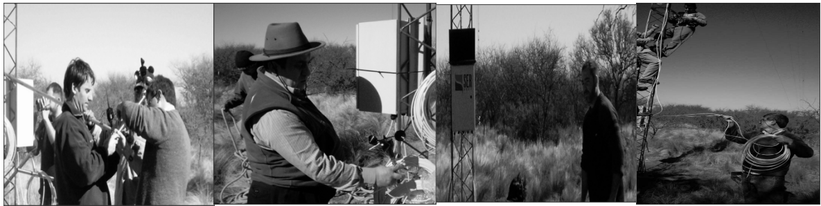
Figura 2: Instalación en la torre de anemómetro, medidor de dirección y data logger.
