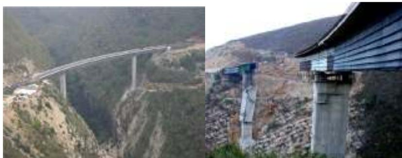
Figura 2: Colapso del puente San Cristóbal.
