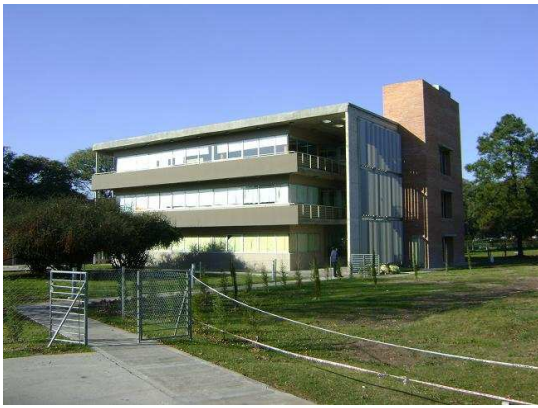
Figura 2. Edificio Técnico Administrativo - PTM - INTI
