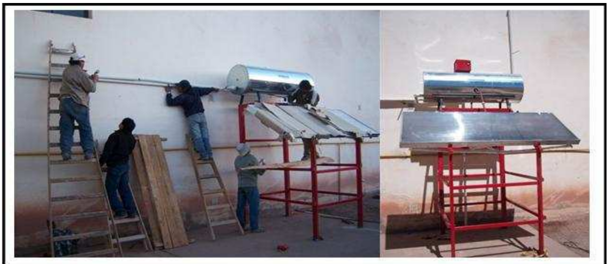
Figura 3: montaje, y calefón solar terminado de instalar.
