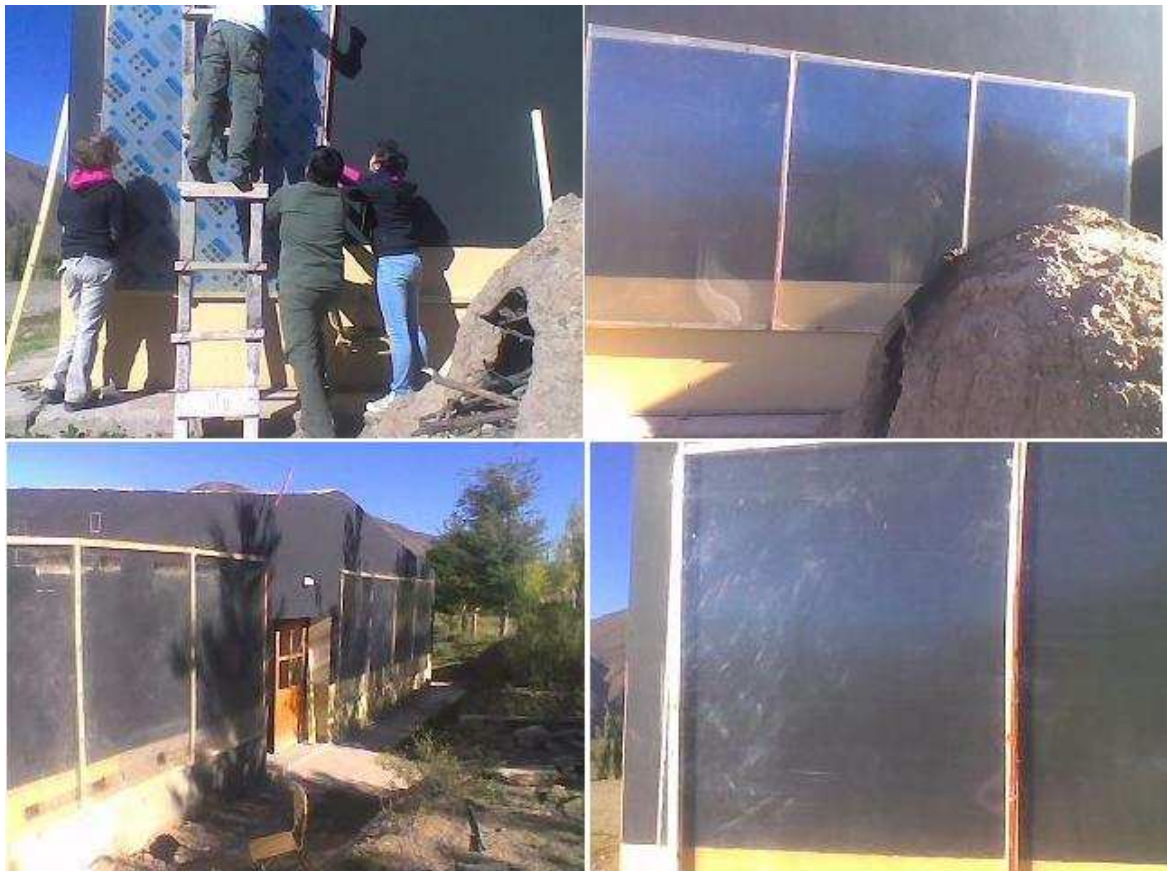
Figura 11: durante la construcción de uno de los muros, y muros terminados.
