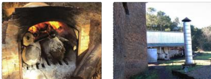
Figura 4.9.- Horno y trampa de humo, ubicación lateral al Barbacú 252
