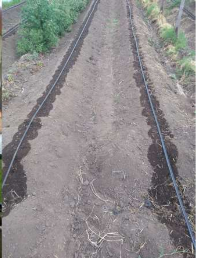
Instalación de drenes
