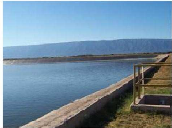
Figura 2. Laguna de Maduración, Módulo 6. Planta de efluentes cloacales de la Capital de Catamarca.
