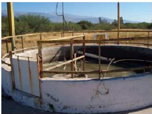
Figura 3: Cámara partidora de caudales. Sitio de muestreo. Planta de efluentes cloacales de la Capital de Catamarca.
