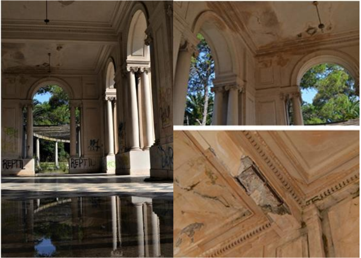
Fig. 5. Pórtico de acceso. 13 de marzo de 2020. Fuente: Autoría y edición propia.
