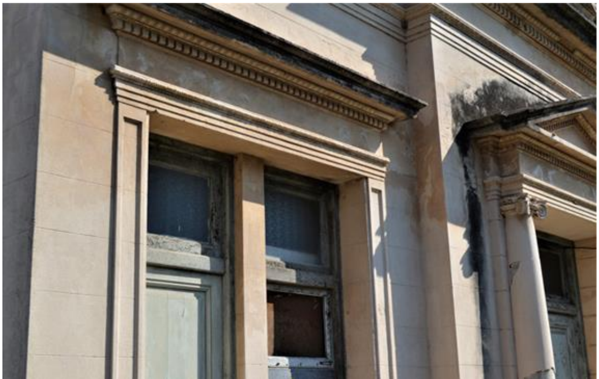
Fig. 6. Lateral del edificio que contiene el escenario. 13 de marzo de 2020. Fuente: Autoría y edición propia.
