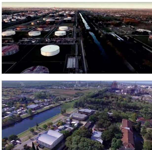
Figura 1-6. Planta de refinería YPF la Plata y alrededores, Bozzano y Canaveri (2018)
