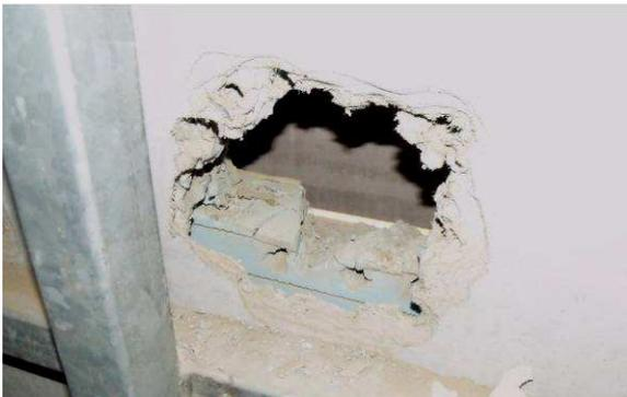
**Figura 9:** Perforación en la placa cementicia y de la barrera de vapor al fijar andamios.
