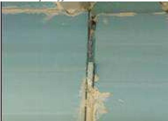
**Figura 12.** Fallas del sellador en las juntas de la placa aislante.
