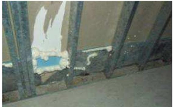
**Figura 8a y 8b.** Reparaciones de la placa de yeso: el reemplazo de las secciones deterioradas, sin resolver el ingreso de aire de alta temperatura y alta humedad, no elimina la formación de condensación y hongos.
