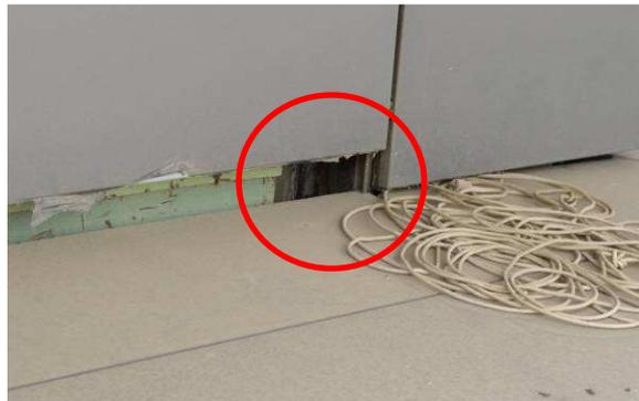
**Figura 10.** Sección faltante de la capa aislante y la barrera de vapor.
