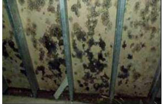
**Figura 7a y 7b.** Crecimiento de hongos sobre placa de yeso en la cámara de aire interior.
