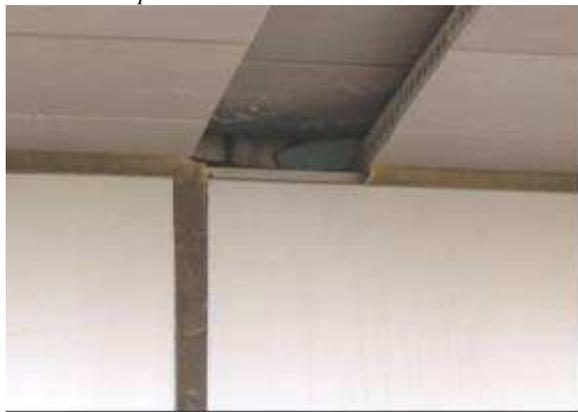
**Figura 13.** Ingreso de aire en la junta de dilatación.
