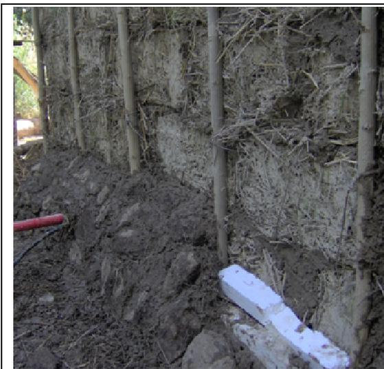
Figura 2a: rehabilitación térmica de una cabaña de madera con bloques externos, sobre base de piedra aislada con poliestireno expandido.
