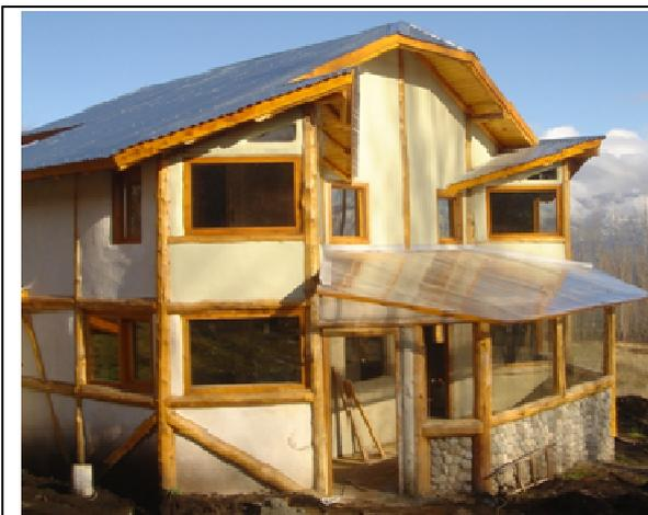
Figura 3a: vivienda unifamiliar con envoltente de bloques de arcilla y paja revocada con arena y cal.
