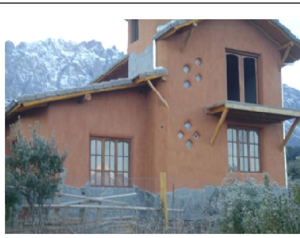
Figura 3b: vivienda unifamiliar con envoltente de bloques de arcilla y paja revocada con arena y arcilla.
