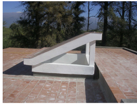
Fig.- 4 Terminación techo modificado
