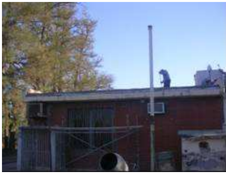
Fig. 3 Construcción techo con aislación
