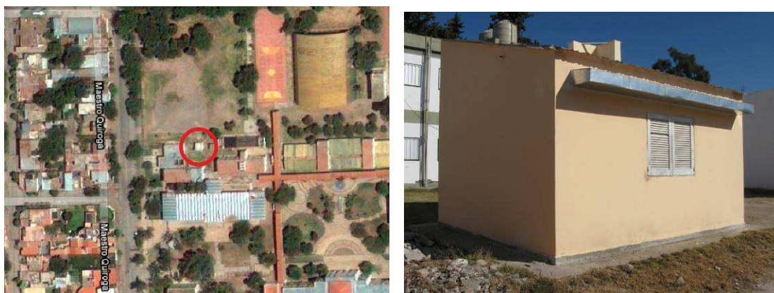
Figura 1: Izquierda, vista de la ubicación; Derecha, exterior de la fachada norte. Sobre la parte superior se ve el sistema anidólico; la ventana que se encuentra debajo fue clausurada.
