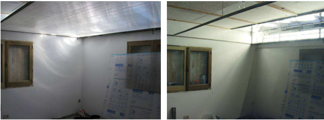
Figura 4: Situación interior con y sin cielo raso difusor (izquierda y derecha).
