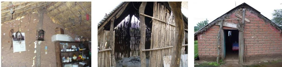
*Figura 3. Uso de caña de bambú y totora en la construcción espontánea del área estudiada. A la izquierda: formando el techo de un ambiente interior utilizado como comedor. En el medio: caña hueca como cerramiento vertical de un fogón. A la derecha: totora bajo chapa de zinc.*
