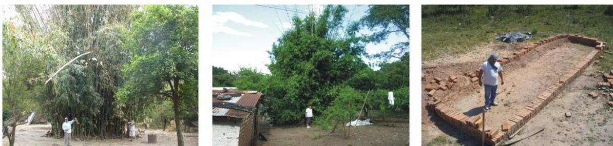
*Figura 4. A la izquierda: mata de bambú ombú. En el medio: mata de caña hueca o tacuara. A la derecha: construcción de paredes laterales de la pileta con ladrillos y tierra. Posteriormente se colocó un plástico negro, se llenó de una solución de agua, boro y bórax y se introdujo las cañas para el proceso de curado.*
