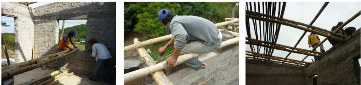
Figura 8. A la izquierda: trabajando con caña de bambú curada y lista para usar. En el medio: Armado la estructura del techo. A la izquierda: Construcción de cielorraso de caña hueca.
