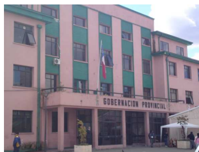
Figura 6: fotografía fachada del edificio.
