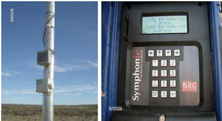
Figura 5 Torre anemométrica y estación automática NRG Now Symphonie
