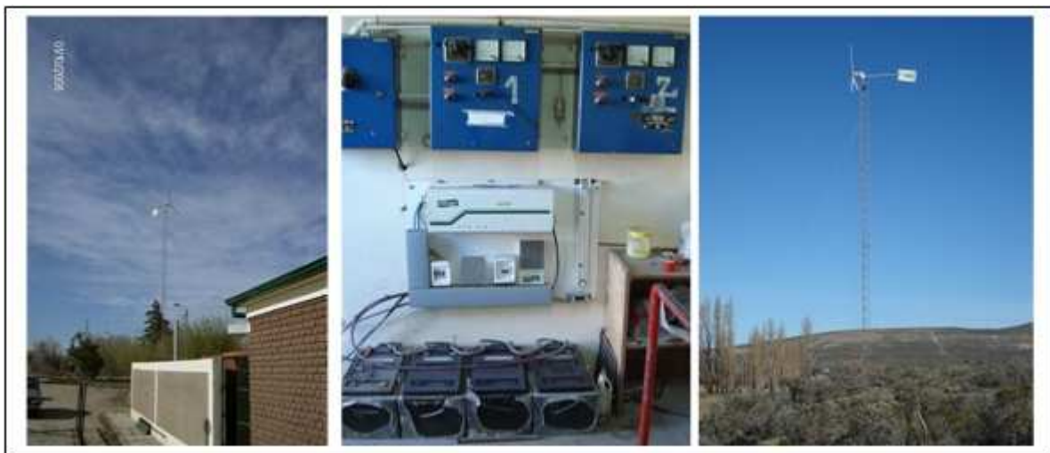
Figura 2 - Sistema INCRO Giacobone en Camping Municipal San Julián (Octubre-2008), Generador Eólico EOLUX 1000 W en San Julián – zona Camping Bombas.
