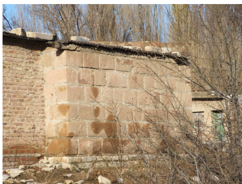
Figura 1- Muro de piedra toba en antigua vivienda de la zona
