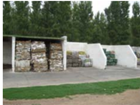
Foto 29: Boxes de acopio techados y al descubierto
