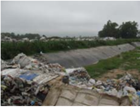
Foto 23: Disposición transitoria de los fardos de rechazo alrededor del módulo de disposición final en construcción.
