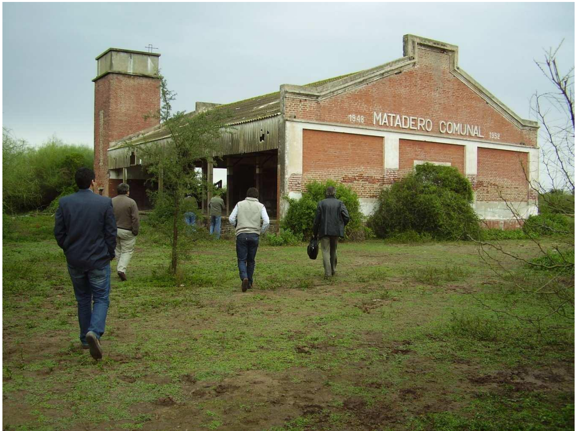
Figura N°7: Foto de funcionarios visitando el viejo Matadero Comunal.
