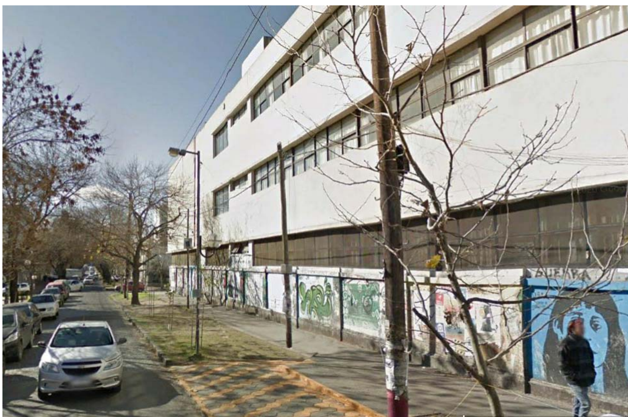
GRUPO URBANO CENTRO – MANZANA “EX DISTRITO” / CONDICIÓN ACTUAL Frente calle 62 / Facultad de Artes – Sede “Fonseca” / aulas Diseño
