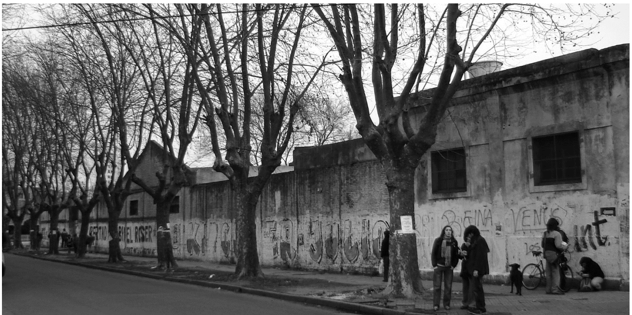
GRUPO URBANO CENTRO – MANZANA “EX DISTRITO” / CONDICIÓN ORIGINAL Frente diagonal 78
