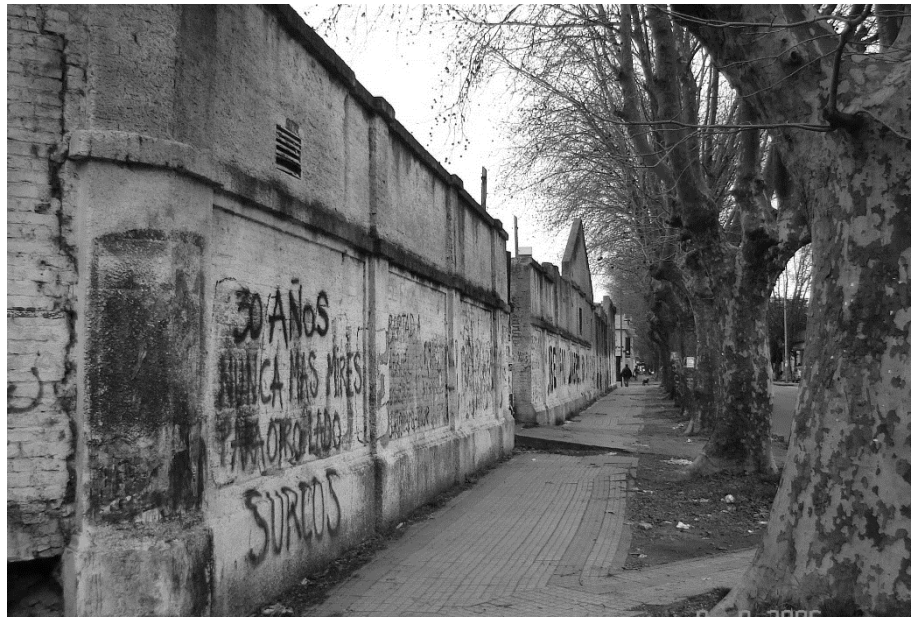
GRUPO URBANO CENTRO – MANZANA “EX DISTRITO” / CONDICIÓN ORIGINAL Frente diagonal 78
