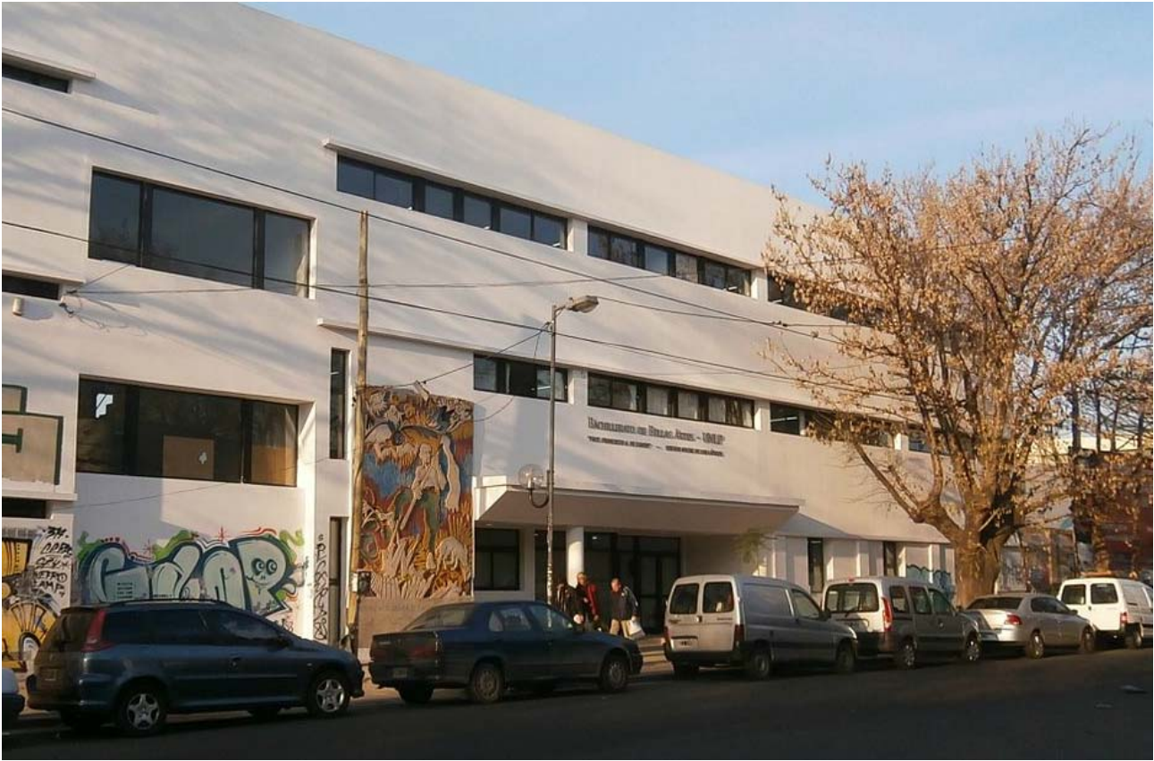
GRUPO URBANO CENTRO – MANZANA “EX DISTRITO” / CONDICIÓN ACTUAL Frente calle 10 / Bachillerato de Bellas Artes – Edificio “Noche de los lápices”
