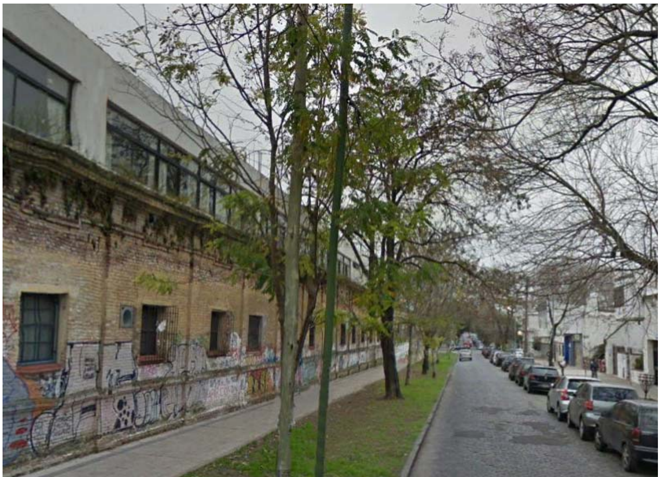
GRUPO URBANO CENTRO – MANZANA “EX DISTRITO” / CONDICIÓN ACTUAL Frente calle 63 / Facultad de Trabajo Social
