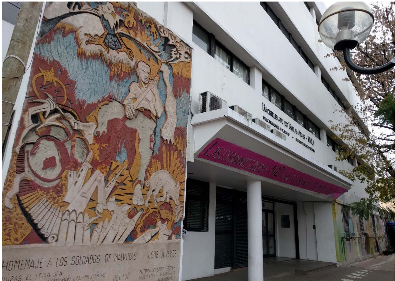
GRUPO URBANO CENTRO – MANZANA “EX DISTRITO” / CONDICIÓN ACTUAL Frente calle 10 / Bachillerato de Bellas Artes – Edificio “Noche de los lápices” / acceso
