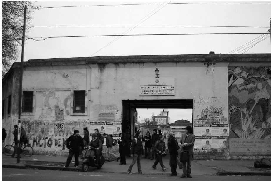
GRUPO URBANO CENTRO – MANZANA “EX DISTRITO” / CONDICIÓN ORIGINAL Frente calle 10 (viejo acceso al Distrito)
