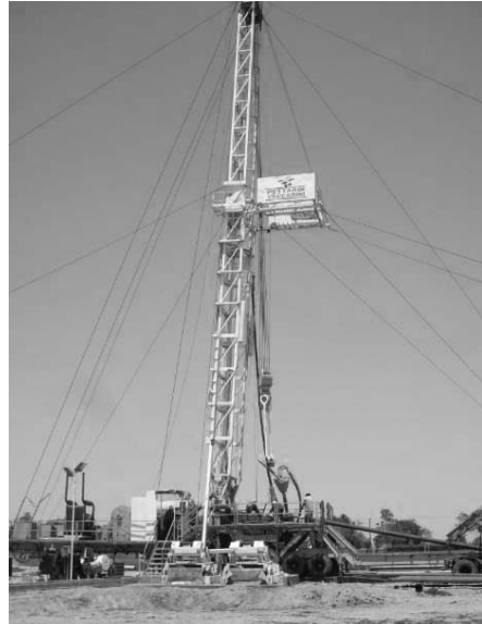
Figura 4. Equipo H-40, bajando cañería.
