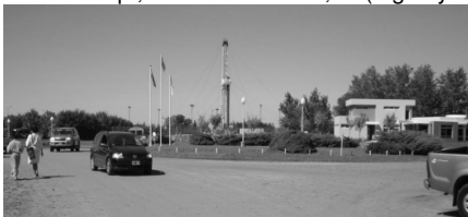
Figura 2. Predio Termal y Equipo de Perforación ERVE-2 (Villa Elisa) 2012.-
