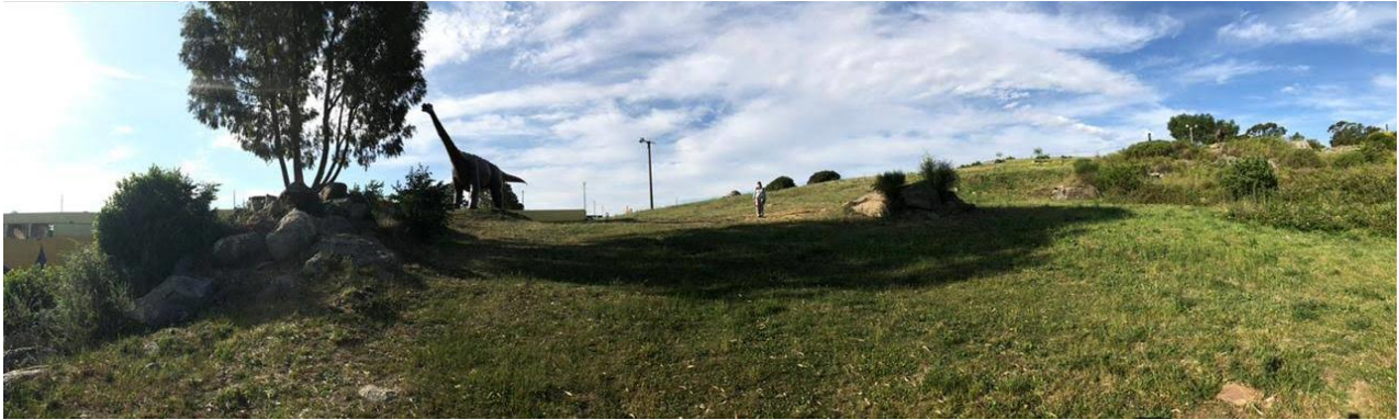
Figura 17.- Acercamiento de el margen derecho de la presa. A la izquierda se observa el afloramiento próximo al eje de la presa, de dimensiones menores y a la derecha parte del afloramiento caracterizado; entre ambos se visualiza una zona de cizalla, meteorizada y cubierta por el suelo vegetal actual.
