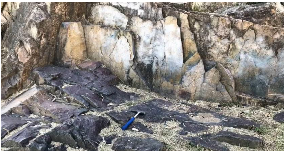
Figura 25.- Material rocoso aflorante ubicado a la altura de la cota de coronamiento de la presa. se puede observar el límite del alcance de la meteorización-alteración en contacto con la roca mayormente conservada.
