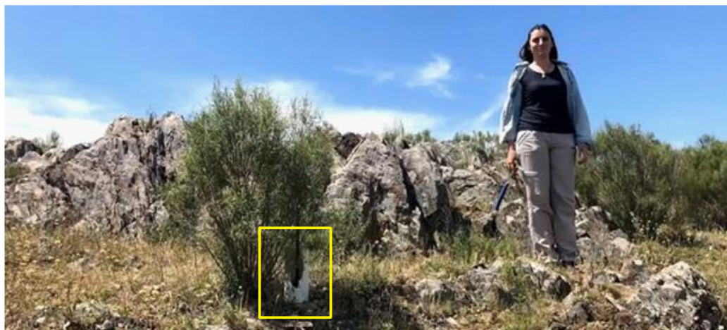
Figura 32.- macizo rocoso aflorante en el margen derecho del proyecto. Abajo en amarillo, destaca el mojón derecho, fijado cuando se realizaron los estudios preliminares para indicar el eje de la futura presa.
