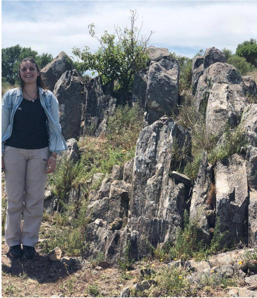
Figura 33.- Macizo rocoso donde se reconoce la incidencia de la alteración-meteorización de manera diferencial y los bloques de matriz rocosa limitados por discontinuidades subverticales. Hacia la base del afloramiento puede observarse el material cizallado y altamente meteorizado.
