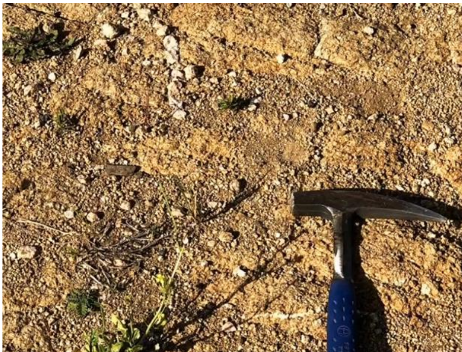
Figura 18.- Detalle del macizo rocoso con grado de meteorización-alteración A4, en el margen derecho de la presa Ramal H. Se observan pequeñas venas de cuarzo con menor grado de meteorización.
