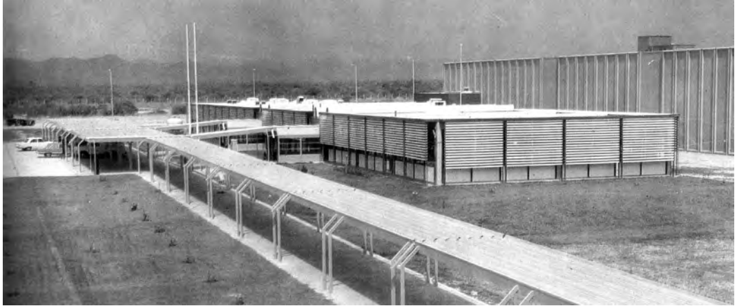
Figura 11: Perspectiva del área de viviendas de la Villa Permanente de Yaciretá. Fuente: Summa , 1978, 129/130, p. 124.
