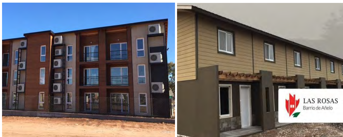
Figura 141. Densificación urbana con construcción de edificios multifamiliares, Añelo. Fuente: Crowdium, 2017; Inmobiliaria Habitar, 2018.
