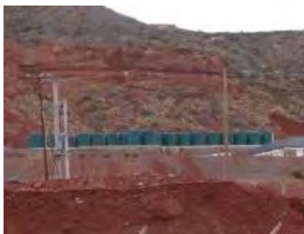
Figura 144. Planta de almacenamiento de agua potable, Añelo. Fuente: Municipalidad de Añelo, 2015 A.
