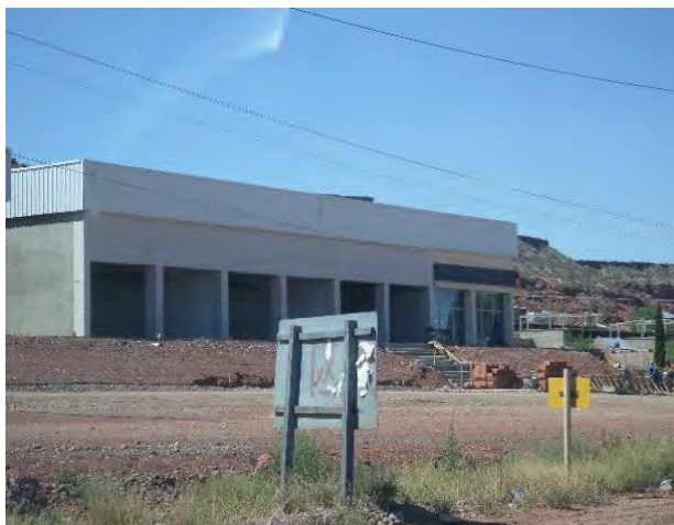
Figura 156. Shopping en construcción. Fuente: Villalba, 2016.
