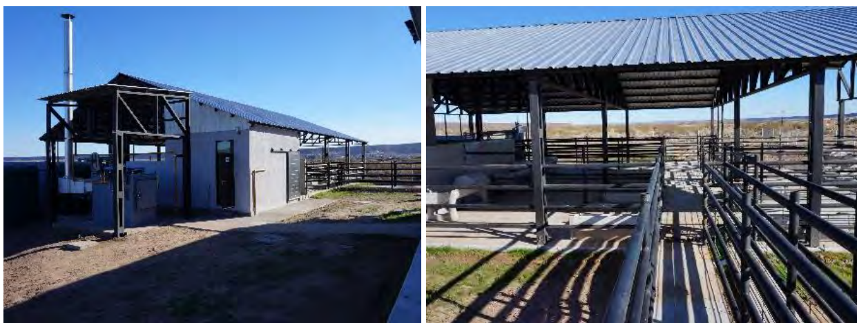
Figura 158. Instalaciones del matadero, Añelo. Fuente: UPEFE, 2018.
