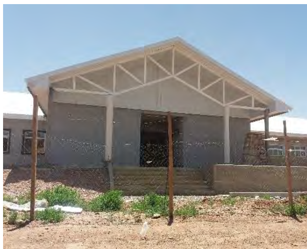
Figura 149. Hospital en construcción Fuente: Villalba, 2016.
