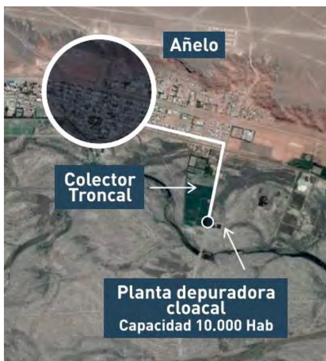
Figura 146. Infraestructura del servicio de saneamiento, Añelo Fuente: BID, Municipalidad de Añelo, Fundación YPF, 2014.
