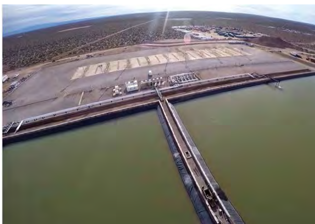
Figura 35. Piletas, área Loma Campana, YPF. Fuente: Sitio web YPF.
