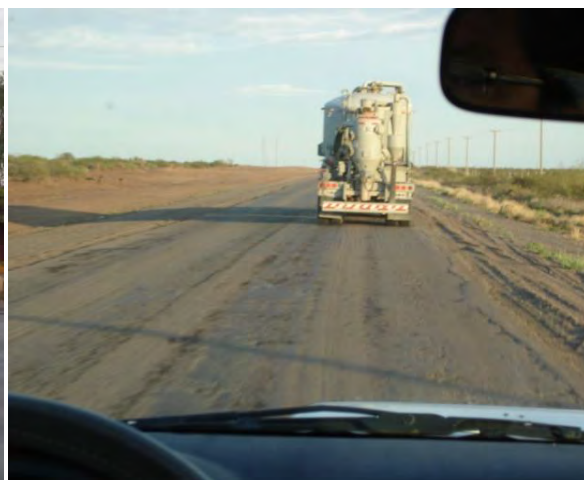
Figura 57. RP N° 7, asfalto deformado sin señalización Fuente: Villalba, 2016.
