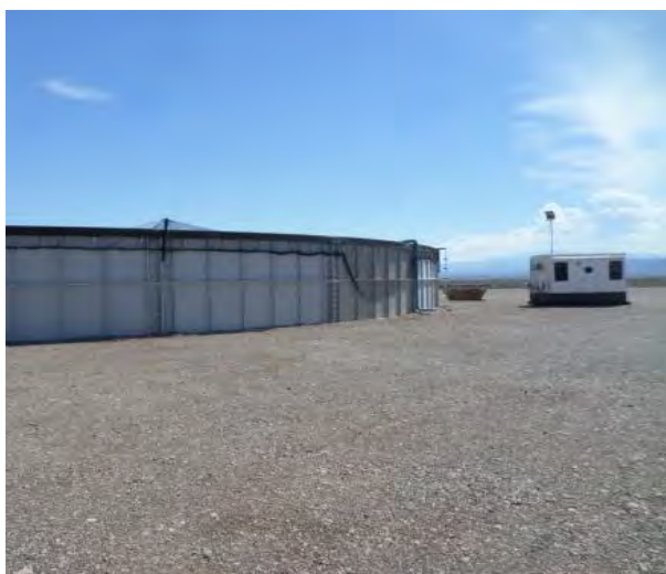
Figura 48. Tanque en Aguada Federal, Neuquén. Fuente: Villalba, 2016.
