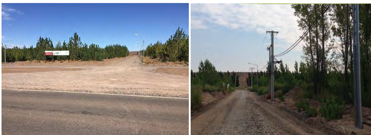
Figura 136. Avances de obra en La Forestada. Fuente: La Forestada, 2018.
