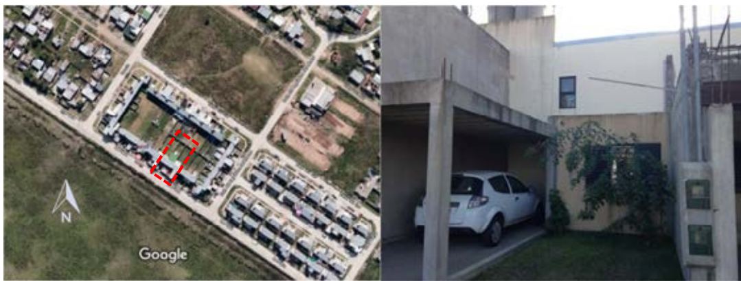
Figura 1: Implantación de la vivienda reciclada. Figura 2: Frente de la vivienda reciclada.
