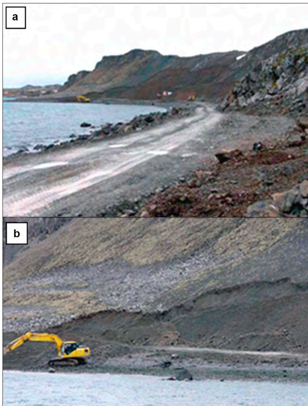
1. a, carretera de acceso a la Cantera N°3, Península Fildes, Isla 25 de Mayo; b, extracción de material en dicha cantera.
