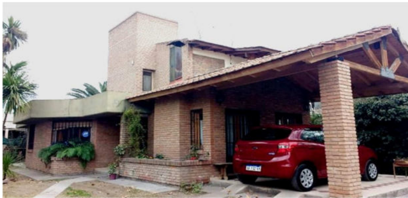
Figura 11: vivienda tradicional construida en ladrillo visto. Se observa la construcción en PB con techo horizontal e liviano inclinado y parte de la construcción en PA.
