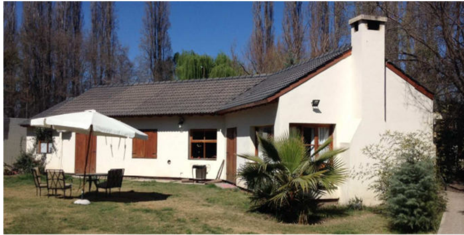
Figura 3: Vista de la fachada N, NE y NO con presencia de ventanas y puertas ventanas con postigones cerrados para la sombra temporal y aleros fijos para la sombra permanente.
