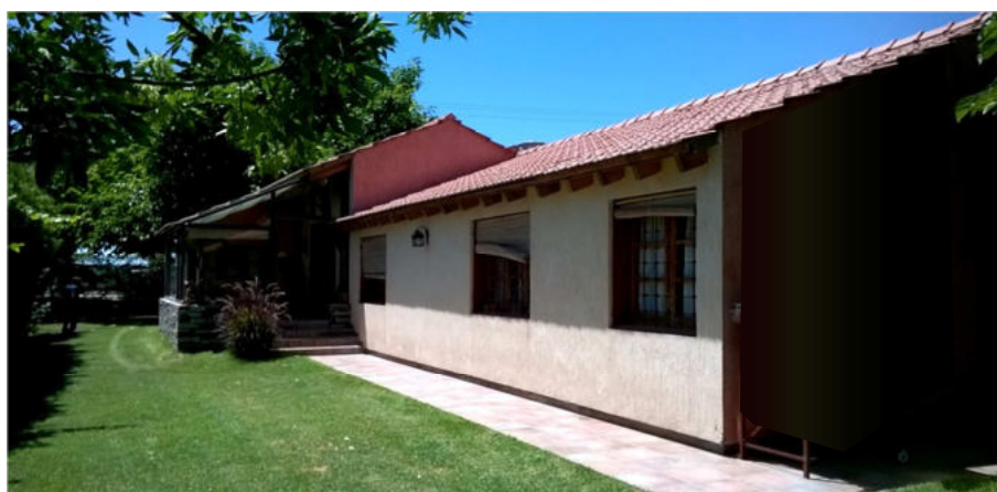
Figura 1: Caso 2, vista de la fachada N de la vivienda. Se observa ventanas de ganancia directa con cortinas de totora como sombra temporal y aleros fijos de sombra permanente.
