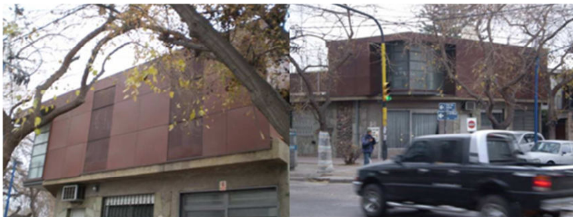
Figura 9: vivienda de construcción tradicional en ladrillo hueco. Izq. se observa la galería sobre fachada Este; der. se observa el frente N de los dormitorios.
