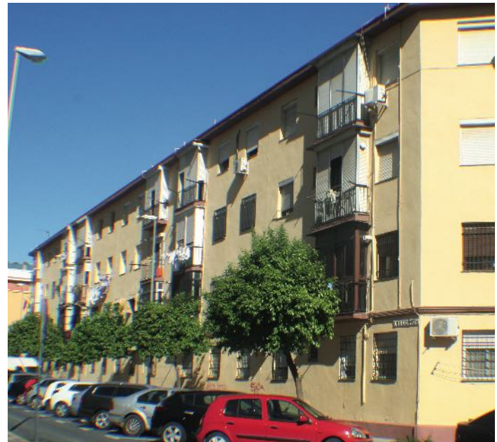
Fig. 4: Bloque de viviendas sociales en Sevilla Fuente: los autores
