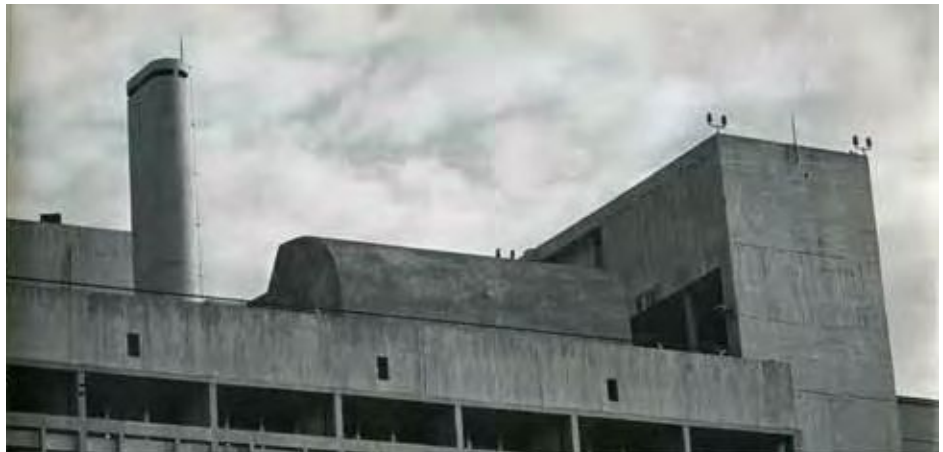
Imagen 28: Vista de la Cubierta del Instituto de Previsión Social de Posadas, Misiones
