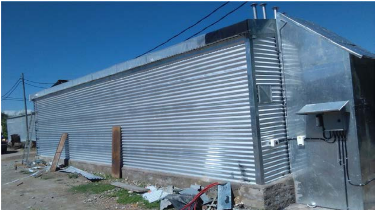
Figura 2: Vista lateral y posterior de la estufa mejorada. A la derecha la unidad de calor que toma aire precalentado del techo.
