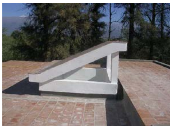
Foto 2.- Terminación techo modificado
