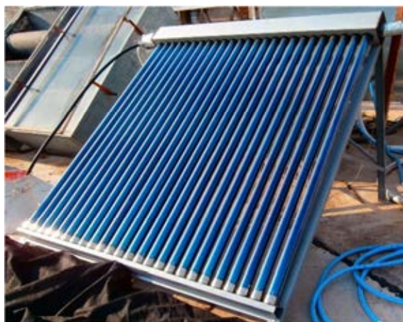
Figura 4: colector solar “manifold” del tipo tubos evacuados sistema water-in-glass
