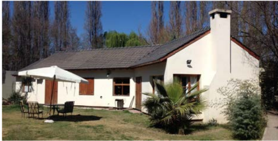
Figura 3: Vista de la fachada N, NE y NO con presencia de ventanas y puertas ventanas con postigones cerrados para la sombra temporal y aleros fijos para la sombra permanente.
