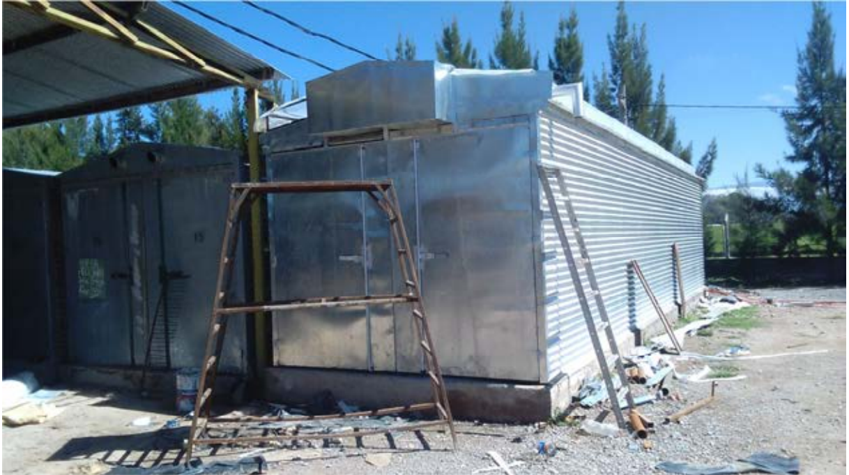
Figura 1: Etapa constructiva de la estufa mejorada. En la parte alta el sistema de recuperación de calor del quemado de gas
