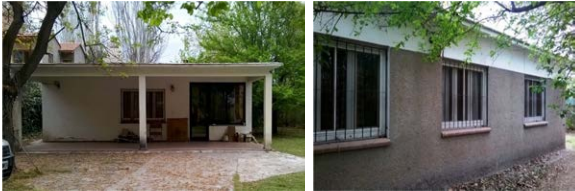
Figura 7.: vivienda de construcción tradicional en ladrillo hueco. Izq. se observa la galería sobre fachada Este; der. se observa el frente N de los dormitorios.
