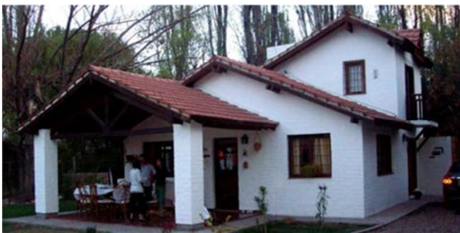
Figura 5: imágenes de la galería abierta y del resto de la fachada N de la misma. Se observa que parte del estar y del dormitorio en PA posee exposición al N.
