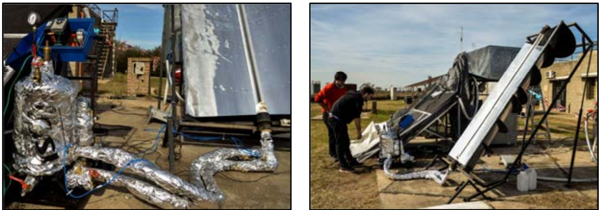
Figura 6. Vistas del circuito térmico construido.
