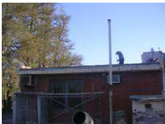
Foto 1.- Construcción techo con aislación
