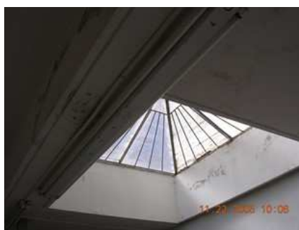
Foto 4.- Lucernario de la sala de lavado.
