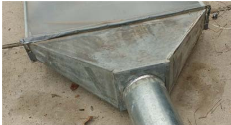
Figura 4. Instalación final de la tobera y ducto de salida del colector.
