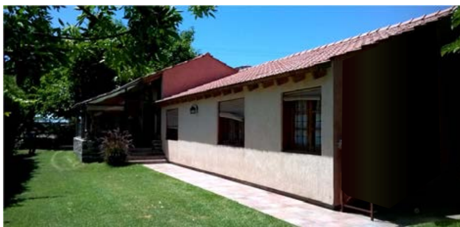
Figura 1: Caso 2, vista de la fachada N de la vivienda. Se observa ventanas de ganancia directa con cortinas de totora como sombra temporal y aleros fijos de sombra permanente.
