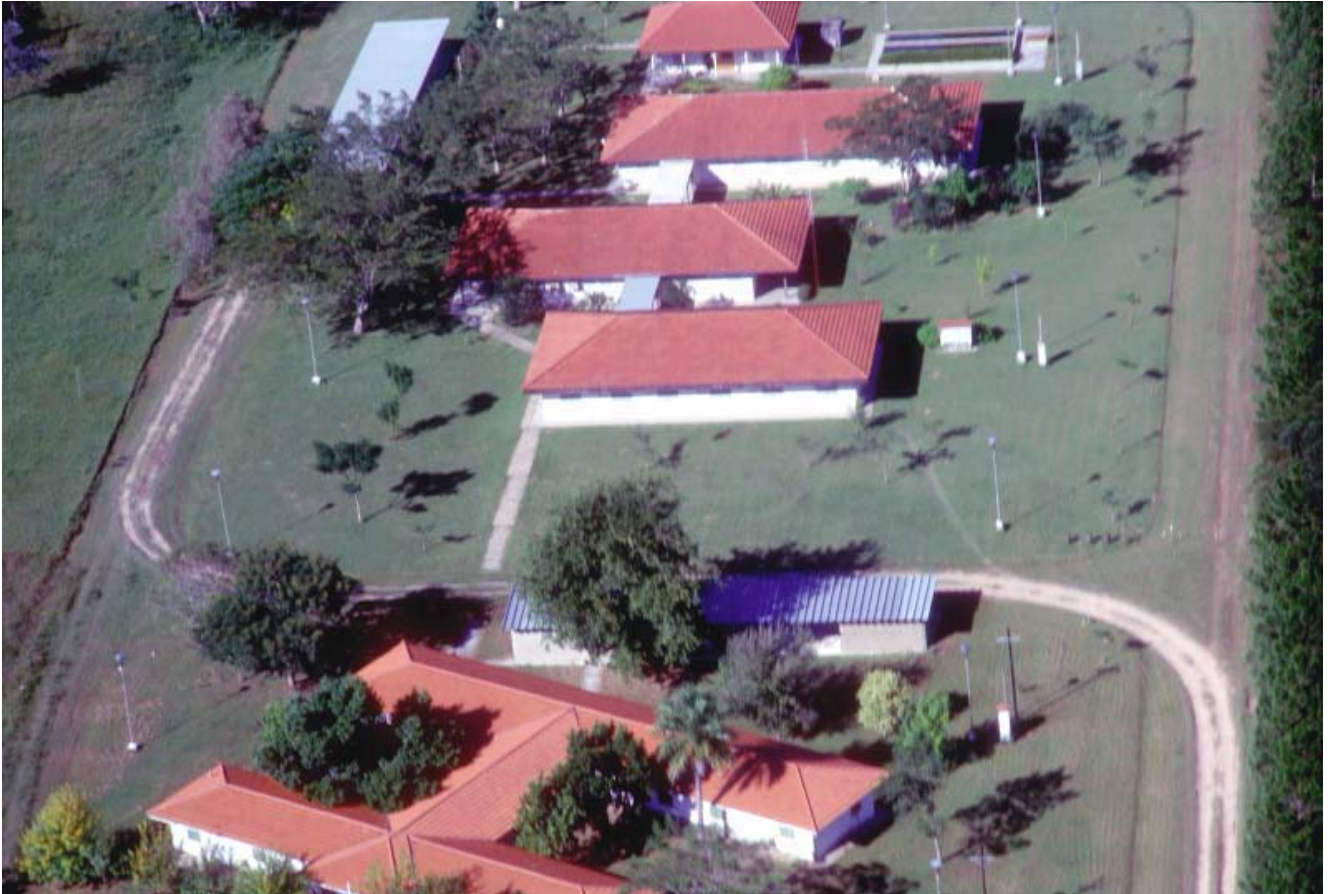
Vista aérea del Campus donde se ubica el CECOAL
