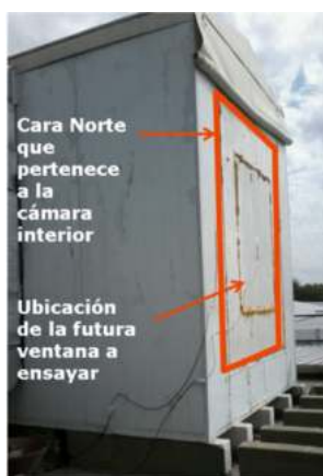
Figura 3: Vista de la Cara Norte
