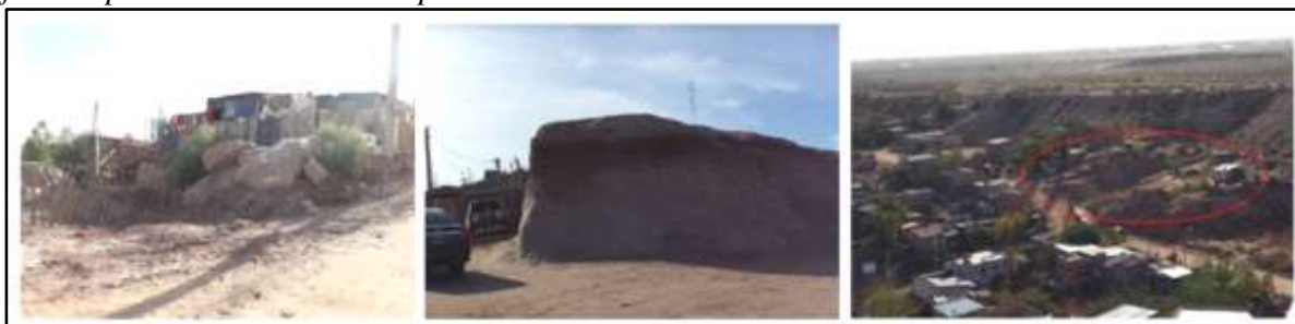
Figura 4: Construcción de viviendas sobre remanentes de erosión y en las laderas de fuertes pendientes disectadas por erosión hídrica
