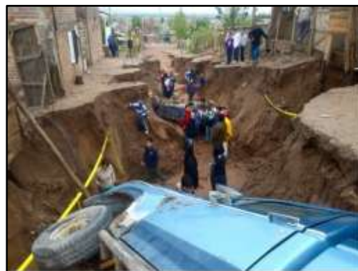
Figura 6: Zanjón producto de la escorrentía superficial encauzada por las calles producto de las precipitaciones intensas del año 2014
