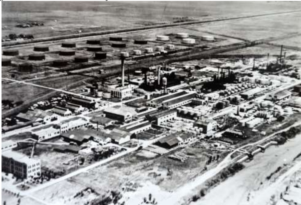
Figura 1. Foto aérea de la Refinería YPF-La Plata, inicio de actividades año 1925
