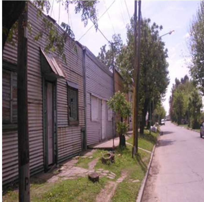
Figura 5. Fachadas de casas de chapa típicas en la ciudad de Ensenada
