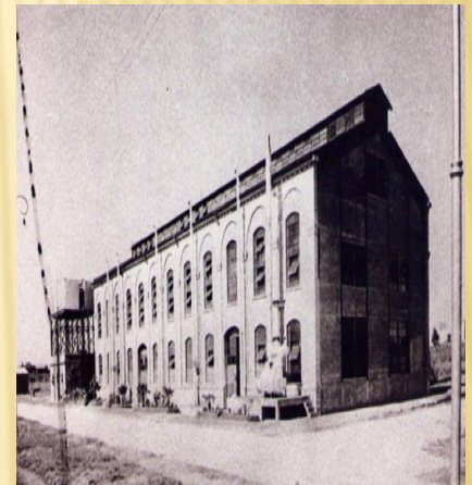
Antiguo edificio de la usina del puerto. Hoy abandonado.
