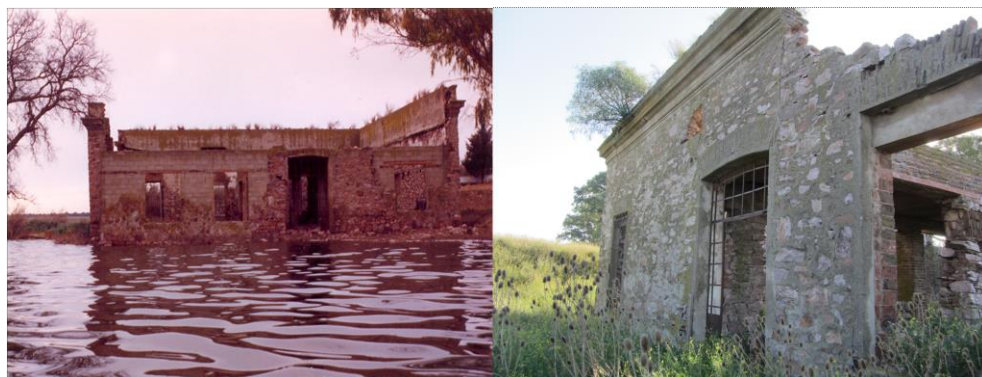
Figura 2. Restos de la casa de Rómulo Franco, a la izquierda en época de inundaciones, a la derecha como se observa en la actualidad. Se puede apreciar la construcción en piedra con detalles en ladrillo (aberturas) y los restos de una puerta metálica que originariamente debe haber llevado vitraux.
