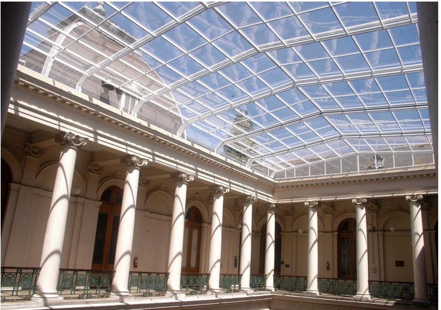
GRUPO URBANO CENTRO – MANZANA PRESIDENCIA / CONDICIÓN GENERADA LUEGO DE LAS INTERVENCIONES Cubierta telescópica en patio central de Edificio Histórico (Presidencia)
