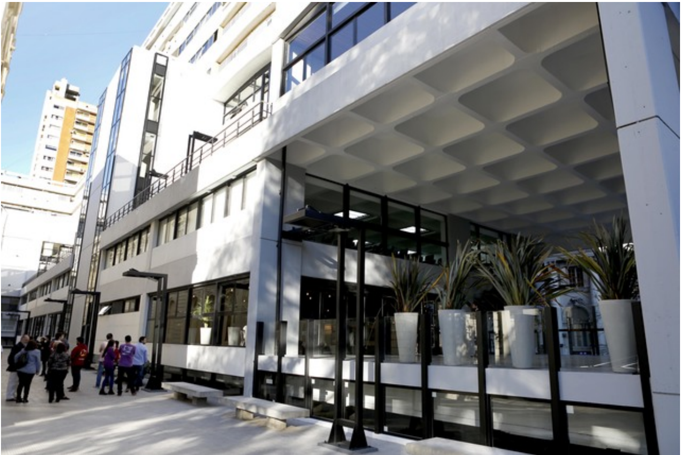
GRUPO URBANO CENTRO – MANZANA PRESIDENCIA / CONDICIÓN GENERADA LUEGO DE LAS INTERVENCIONES Pasaje del Bicentenario
