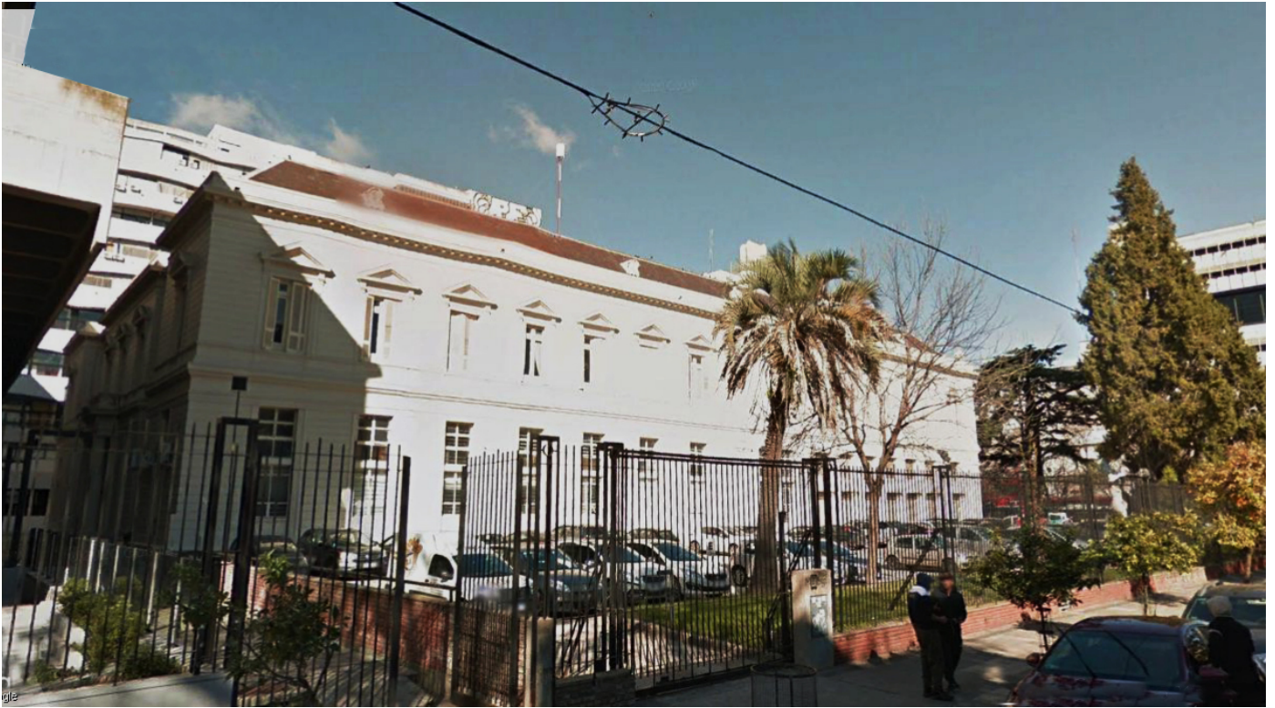
GRUPO URBANO CENTRO – MANZANA PRESIDENCIA / CONDICIÓN GENERADA LUEGO DE LAS INTERVENCIONES Fachada calle 47 Edificio Histórico (Presidencia)
