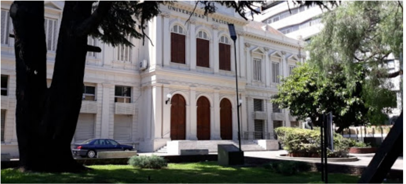
GRUPO URBANO CENTRO – MANZANA PRESIDENCIA / CONDICIÓN GENERADA LUEGO DE LAS INTERVENCIONES Edificio Histórico (Presidencia)
