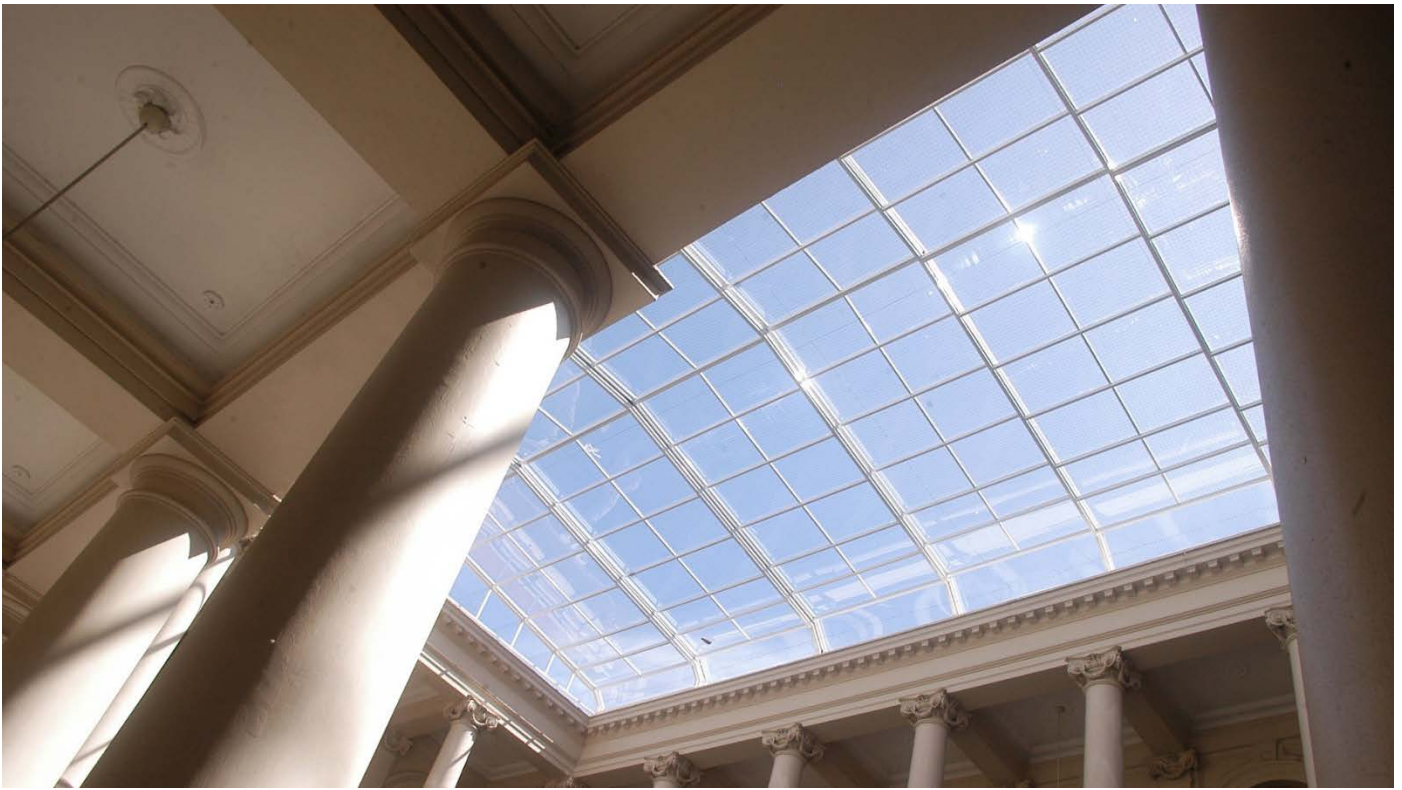
GRUPO URBANO CENTRO – MANZANA PRESIDENCIA / CONDICIÓN GENERADA LUEGO DE LAS INTERVENCIONES Cubierta telescópica en patio central de Edificio Histórico (Presidencia)
