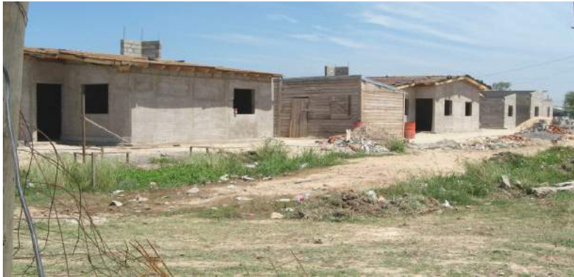
Figura 10: Viviendas construidas en Barrio Instituciones Unidas. 2013
