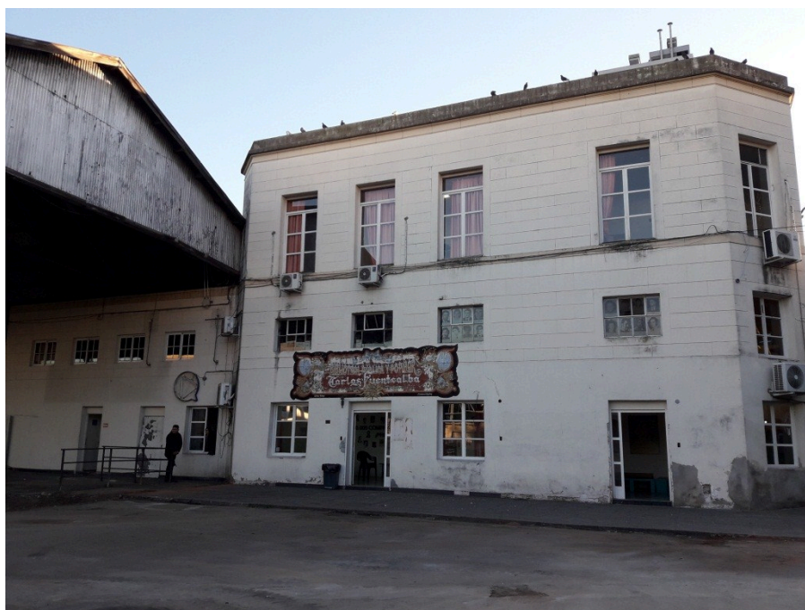
Figura 6. Vista del exterior del edificio donde se emplaza el Salón de Usos Múltiples. Autoría propia, diciembre de 2017.
