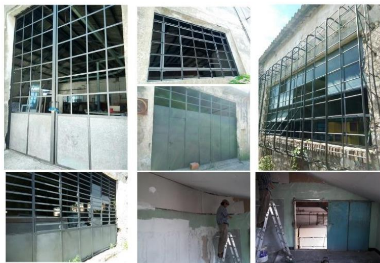
Figura 26. Mejoras realizadas por el departamento de obras de la FAU UNLP. Fuente: Elaboración propia. 2018.
