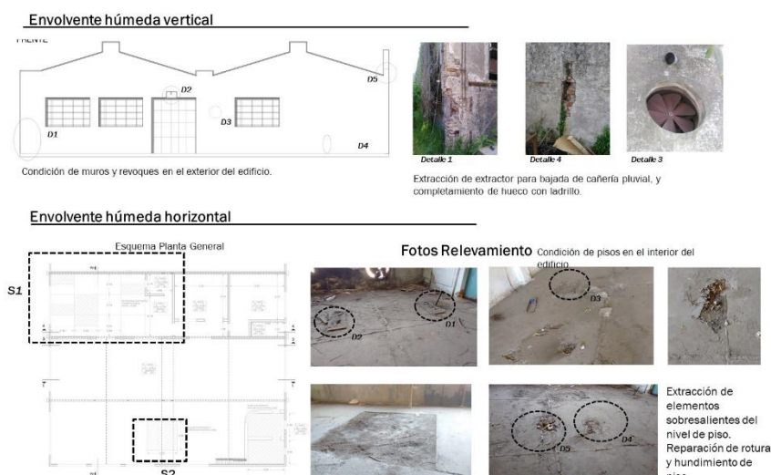
Figura 11. Ejemplo de Fase II: Relevamiento de subsistemas. Fuente: Elaboración propia, 2017.
