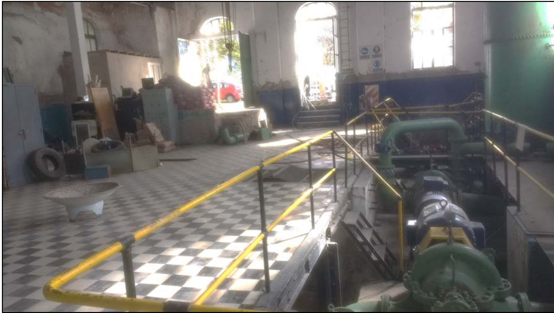
Figura N° 9. Fotografía de la sala de máquinas de la Usina del Parque San Martín. Se pueden observar en el margen izquierdo ladrillos y materiales de construcción para refaccionar sectores del predio 43 .
