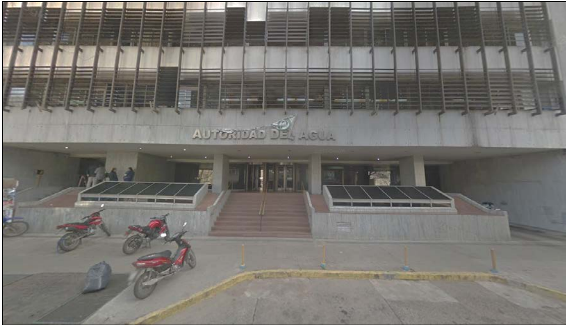
Figura N° 13. Acceso principal al Edificio Central 81 . Se destaca la presencia de un pasacalle de "SOSBA" sobre la puerta de ingreso (en la imagen aparece enrollado).
