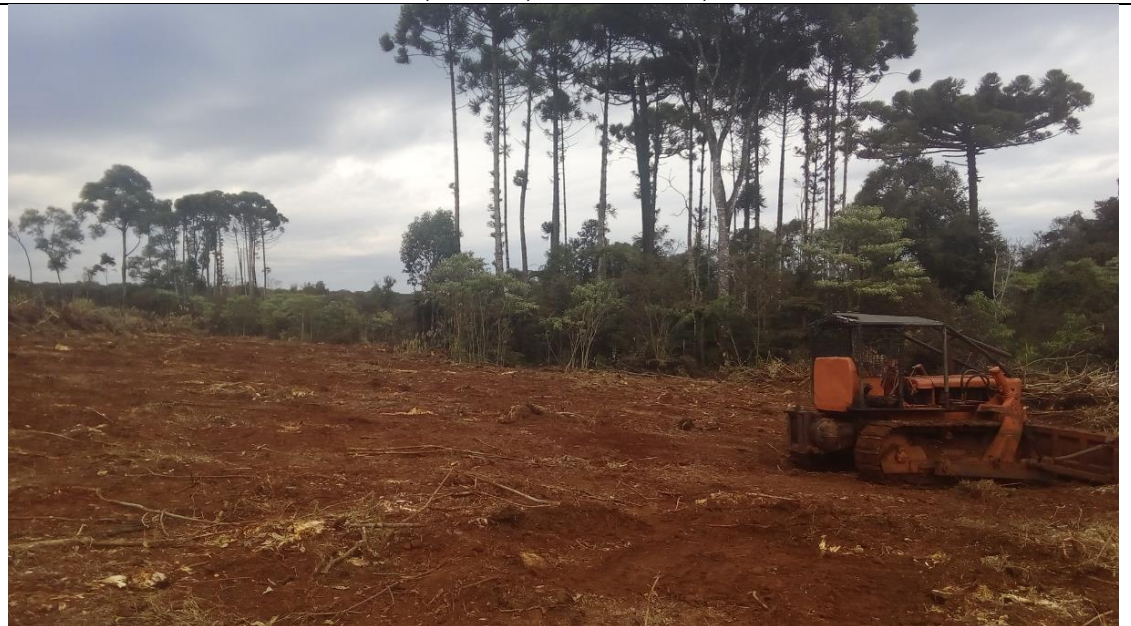
Figura A. 4. Topadora limpiando el terreno, suelo desnudo y agregado de retención. Ubicación, CAMB, San Antonio, Misiones.
