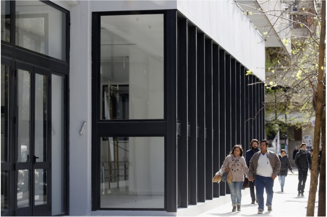
EDIFICIO "SERGIO KARAKACHOFF" – NUEVA FACHADA CALLE 48
