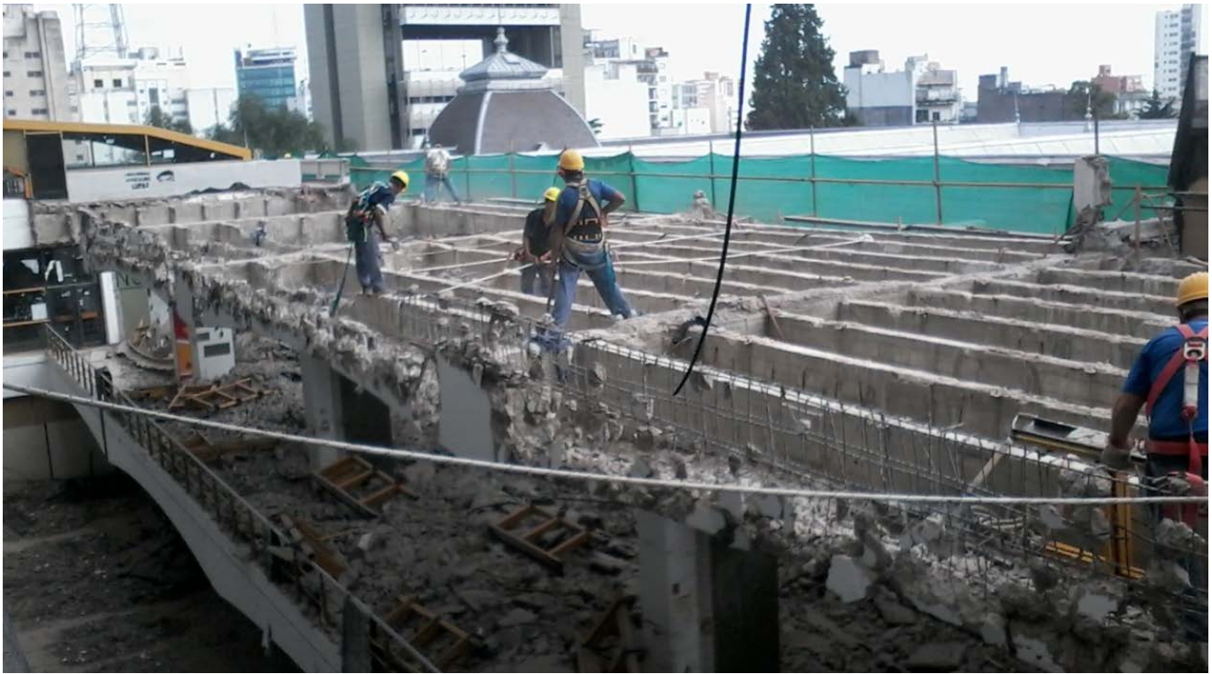
EDIFICIO "SERGIO KARAKACHOFF" / OBRAS DE DEMOLICIÓN Planta segunda
