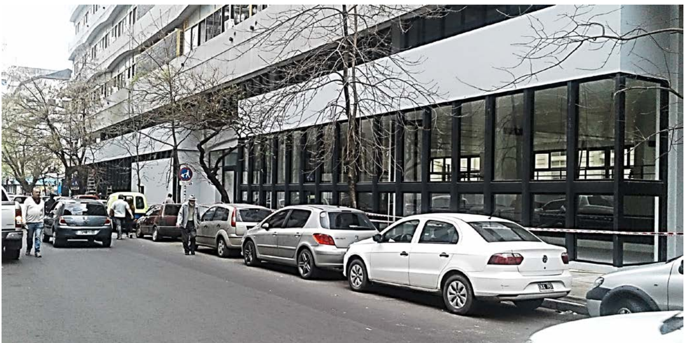
EDIFICIO "SERGIO KARAKACHOFF" – NUEVA FACHADA CALLE 48
