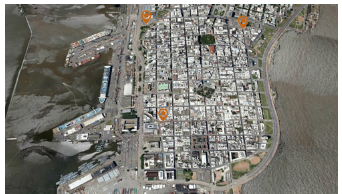
Localización aérea de las obras de la Ciudad Vieja | foto Federación de Cooperativas de Vivienda de Usuarios por Ahorro Previo (FECovi), titular de todas las imágenes de la contribución
