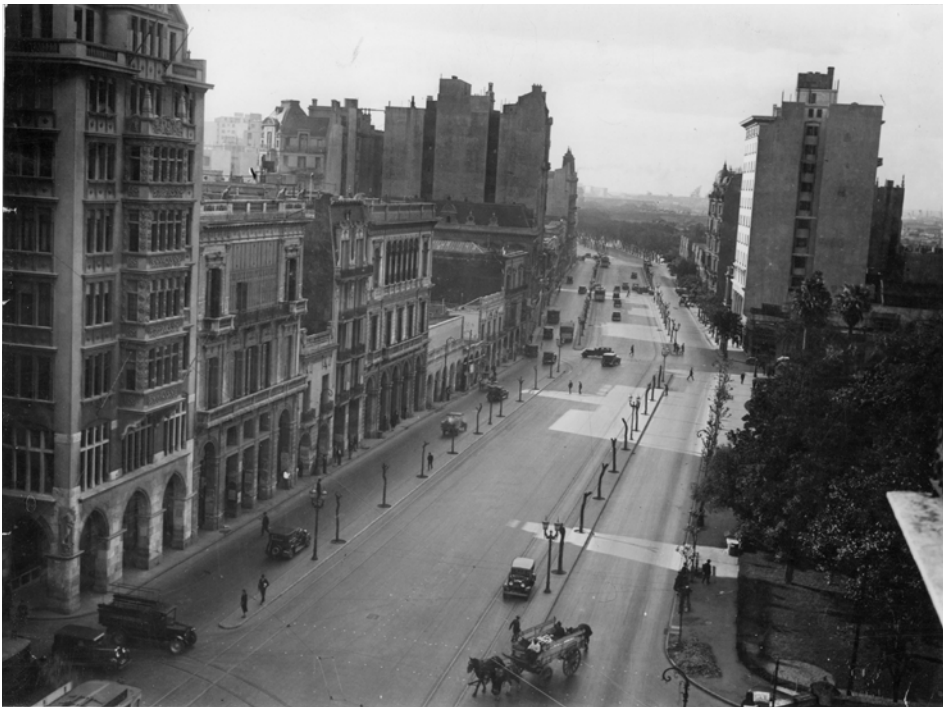
Figura 10. Vista de la Avenida Leandro N. Alem hacia el norte. A la derecha el edificio Bunge y Born. Nótese las diferencias de alturas y de diseño de las recovas Colección AGN 10045, C70.
