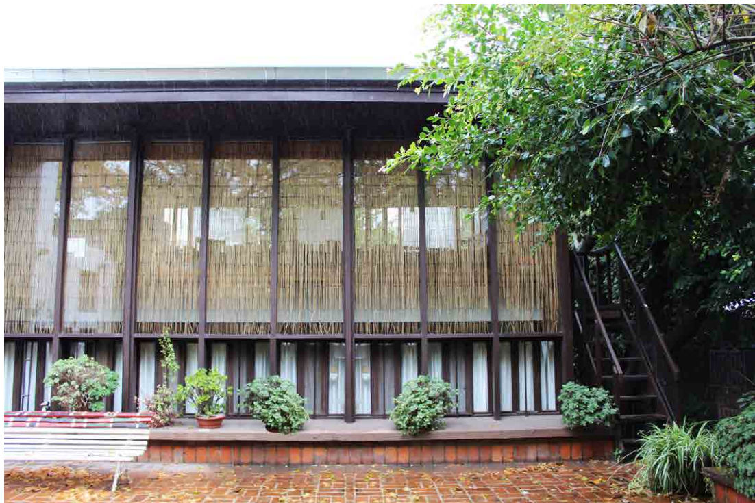
Figura 1. Casa Grebol en Mar del Plata de los arquitectos C. Lenci, J. M. Escudero y R. Kuri, 1971. Foto de la autora.
