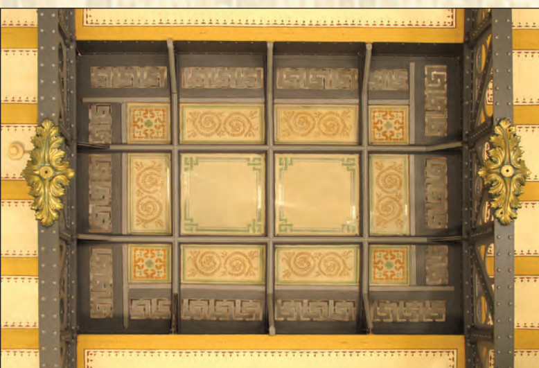
Techo abovedado de sala de exhibición IV. Detalle del hierro forjado y calado, con remaches de bronce cuya función es sólo decorativa.
