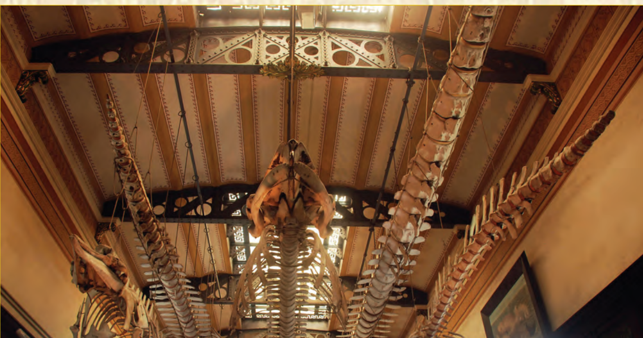
Cabriadas metálicas de hierro forjado - Sala de Anatomía Comparada, exhibición histórica.
