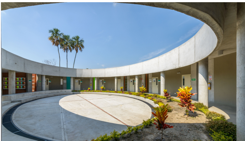
Escuela de Música. Candelaria, Colombia. Espacio Colectivo Arquitectos, 2016.
