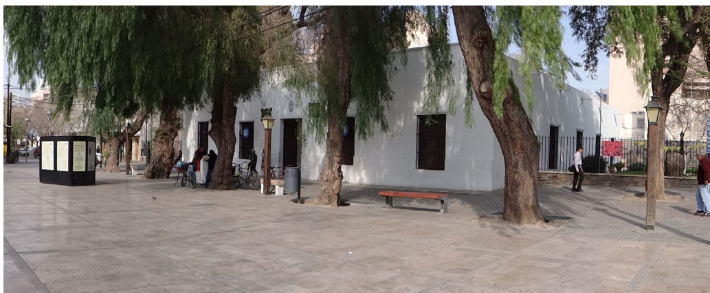
Figura 3. Vista actual del edificio desde la esquina noreste.
